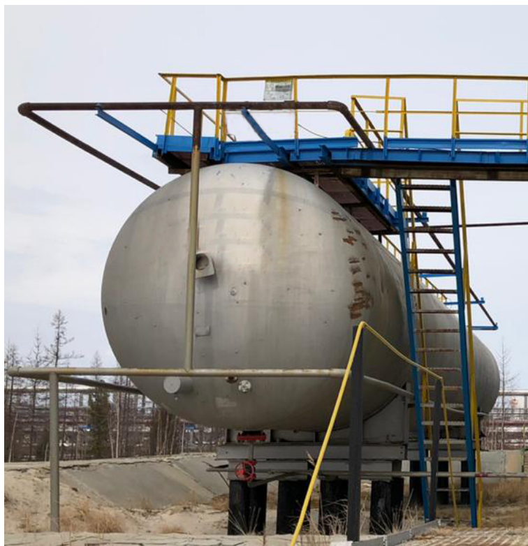
Рисунок 1 – Общий вид резервуаров РГС-200
