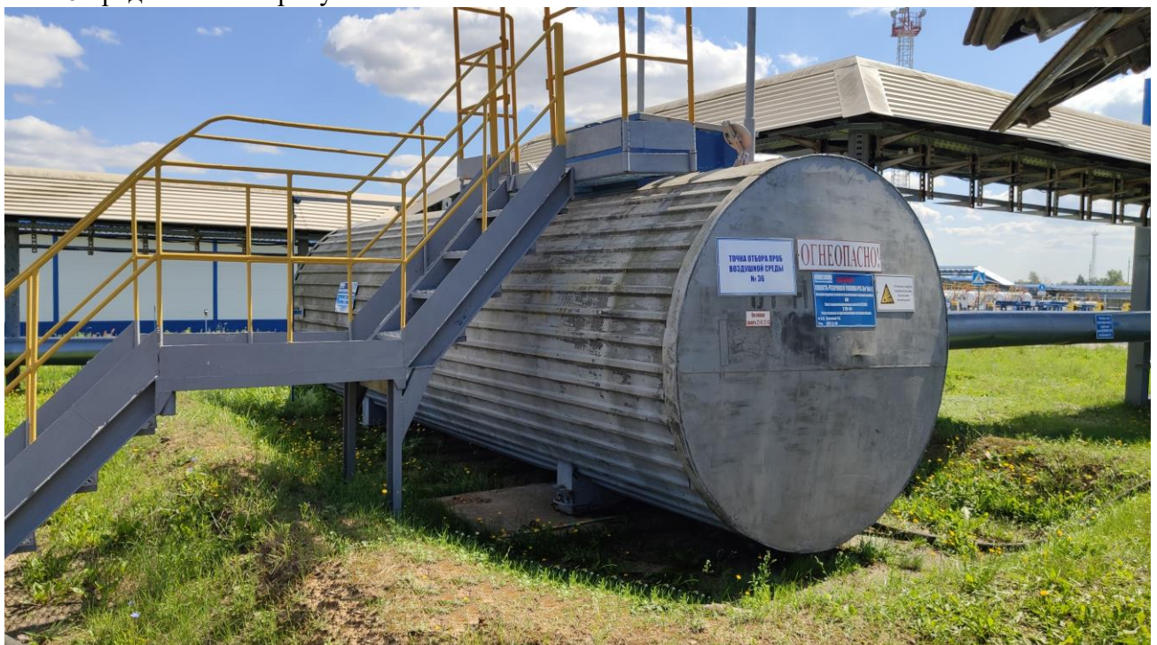
Рисунок 1 – Общий вид резервуара РГС-20
