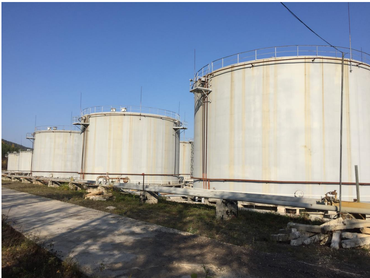
Рисунок 1 – Общий вид резервуаров вертикальных стальных цилиндрических РВС-3000
