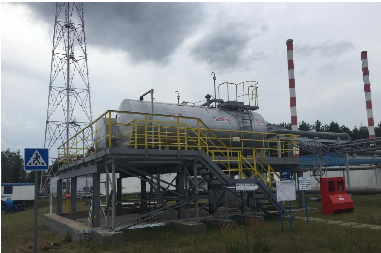
Рисунок 1 – Общий вид резервуаров РГС-20
