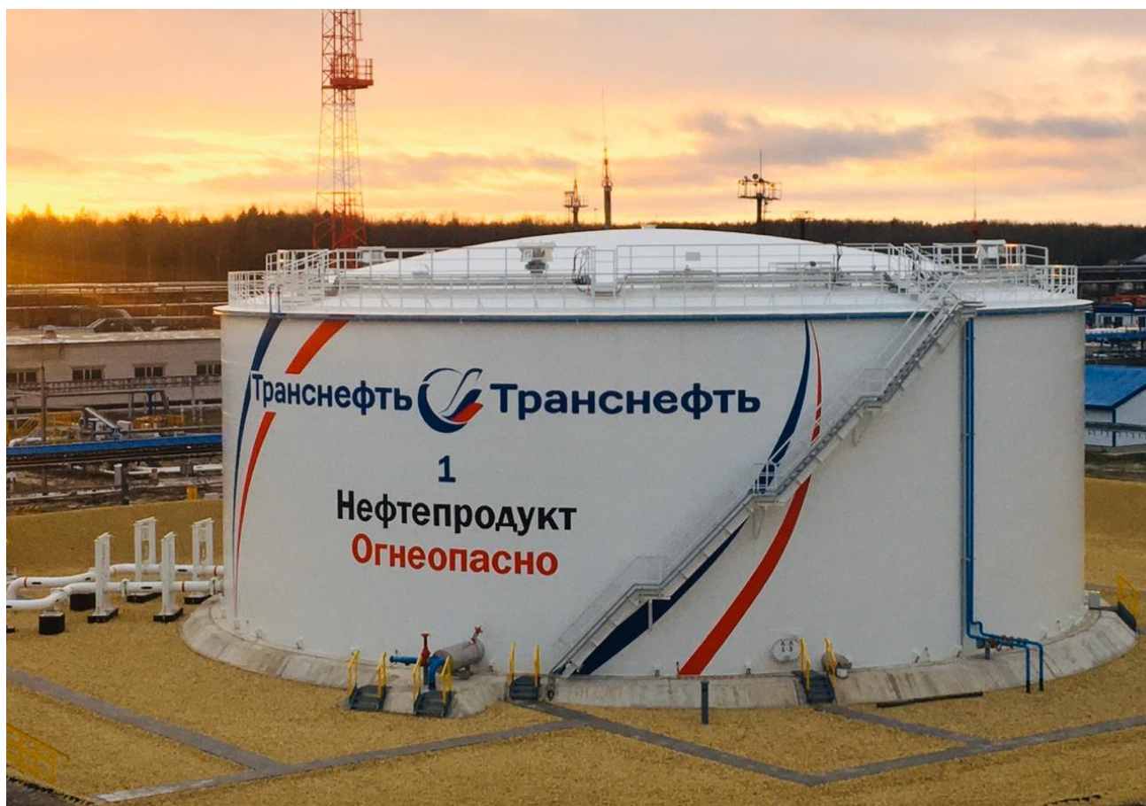
Рисунок 1 – Общий вид резервуара РВС-10000
