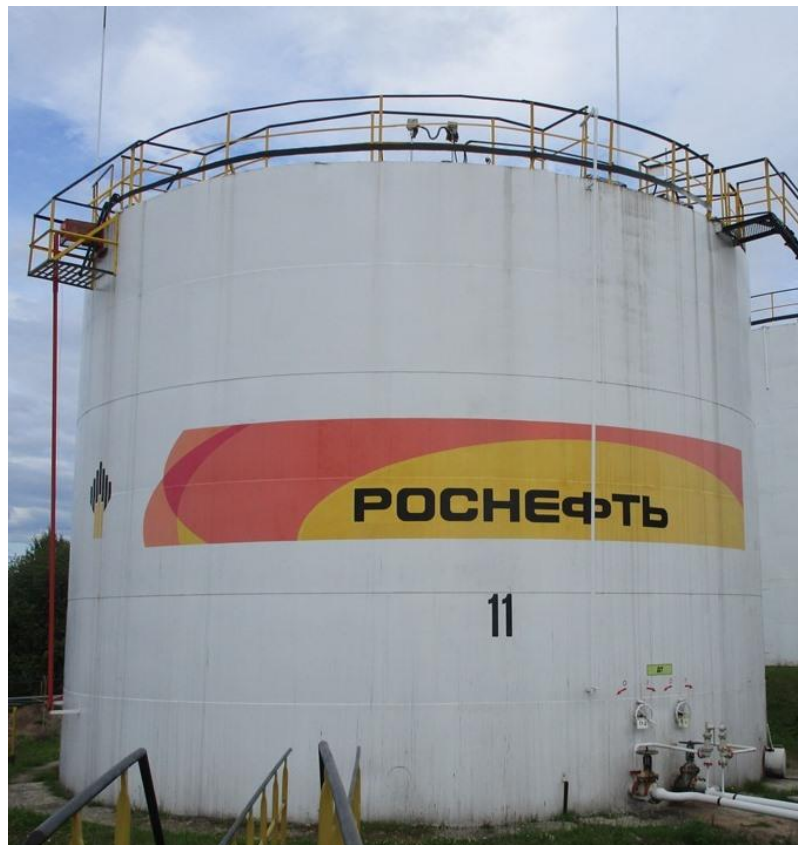
Рисунок 2 – Общий вид резервуара стального вертикального цилиндрического РВС-200
