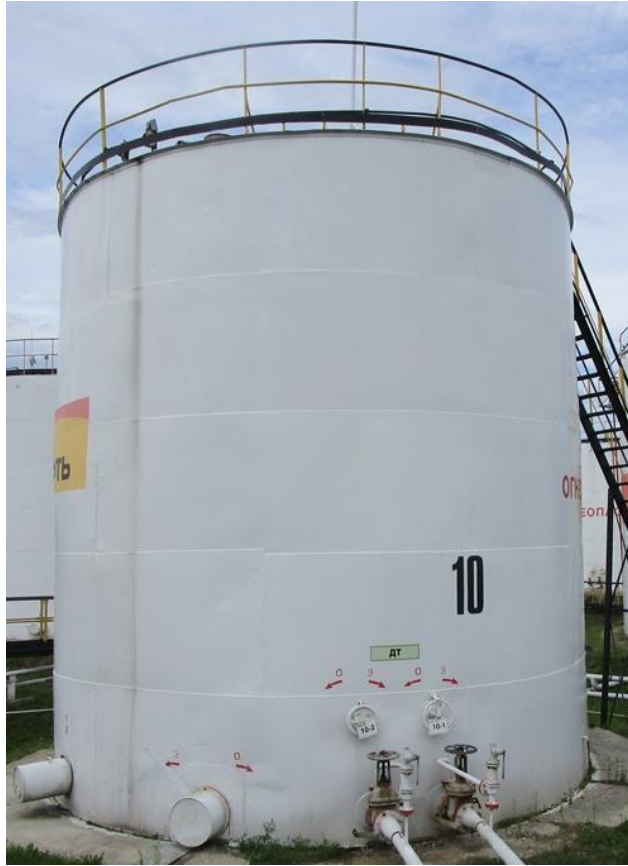
Рисунок 1 – Общий вид резервуара стального вертикального цилиндрического РВС-100
