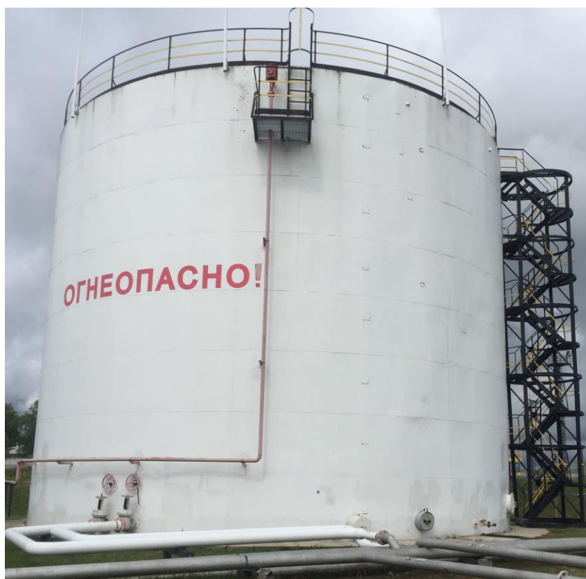
Рисунок 4 – Общий вид резервуара стального вертикального цилиндрического РВС-2000
