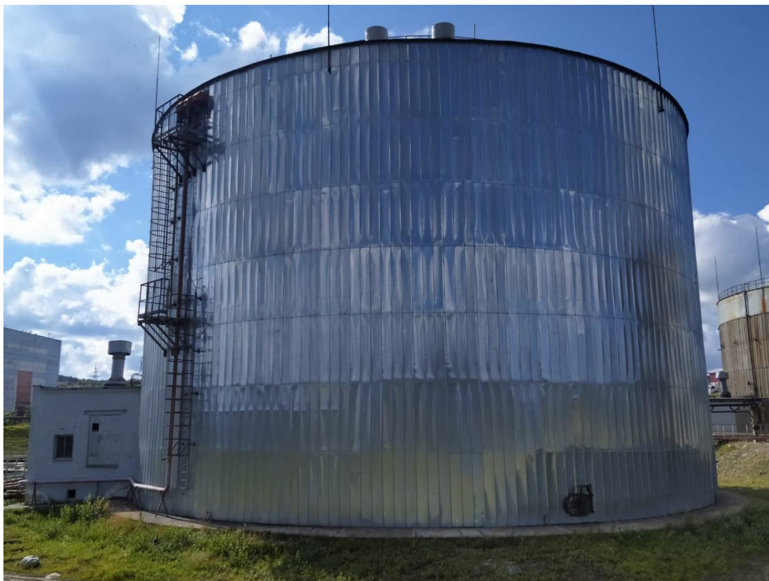
Рисунок 1 – Общий вид резервуара РВС-10000
