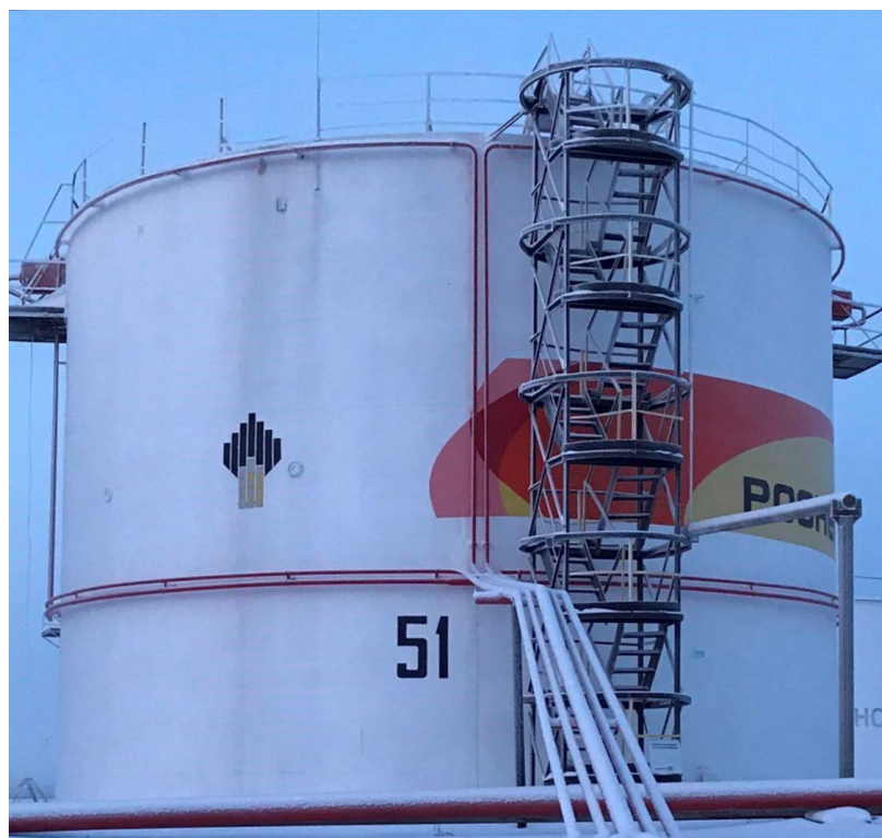
Рисунок 1 – Общий вид резервуаров стальных вертикальных цилиндрических РВС-2000
