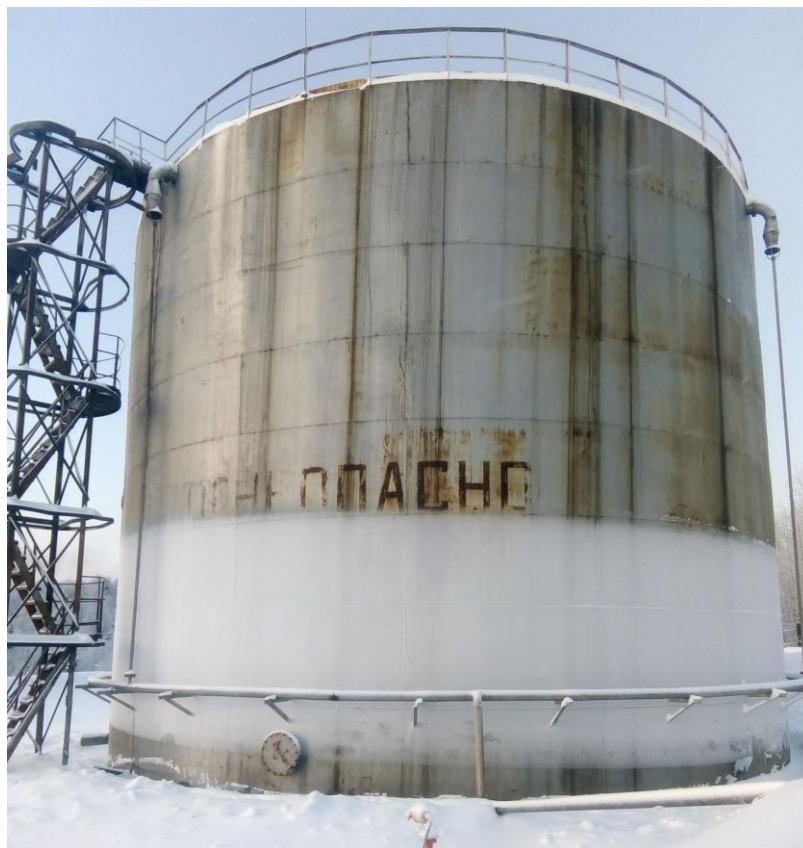
Рисунок 1 – Общий вид резервуара стального вертикального цилиндрического РВС-2000
