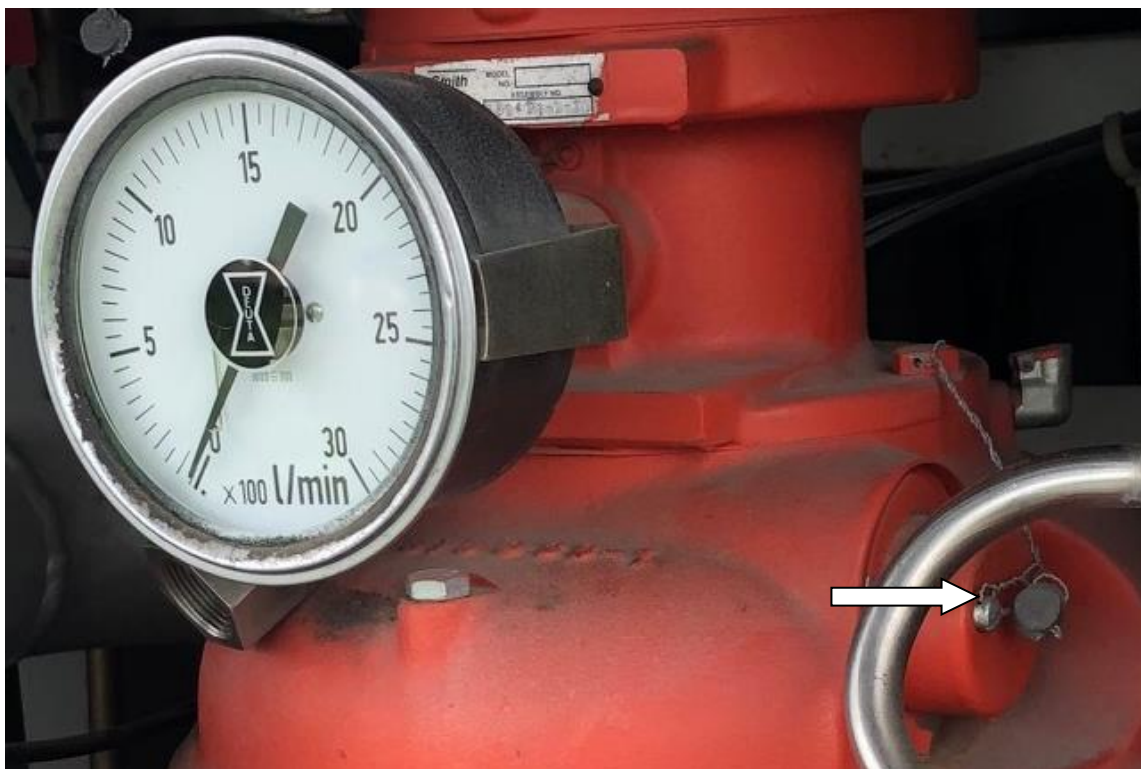
Рисунок 2а - Место пломбирования и нанесения знака поверки счетчика жидкости лопастного SF-60-DI
