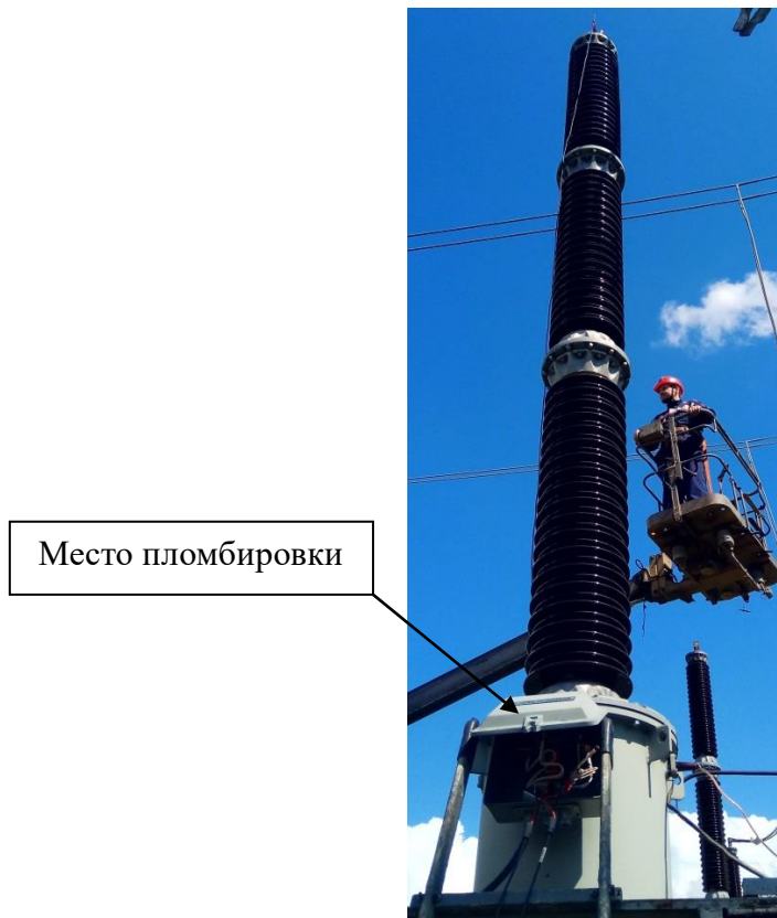
Рисунок 1 – Общий вид средства измерений и схема пломбировки от несанкционированного доступа
