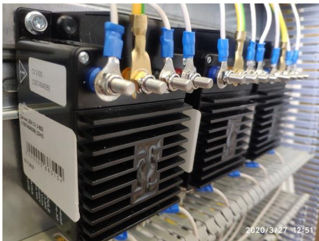
Рисунок 15 – Преобразователи напряжения CV3-500. Вид внешний
