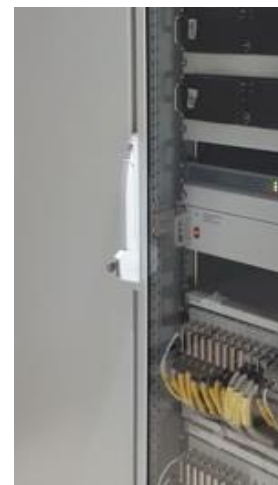
Рисунок 16 – Замок двери стойки приборной АИИС. Вид внешний
