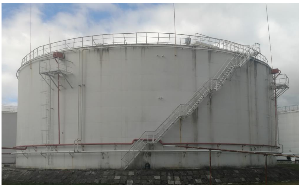
Рисунок 1 – Общий вид резервуара РВС-10000
