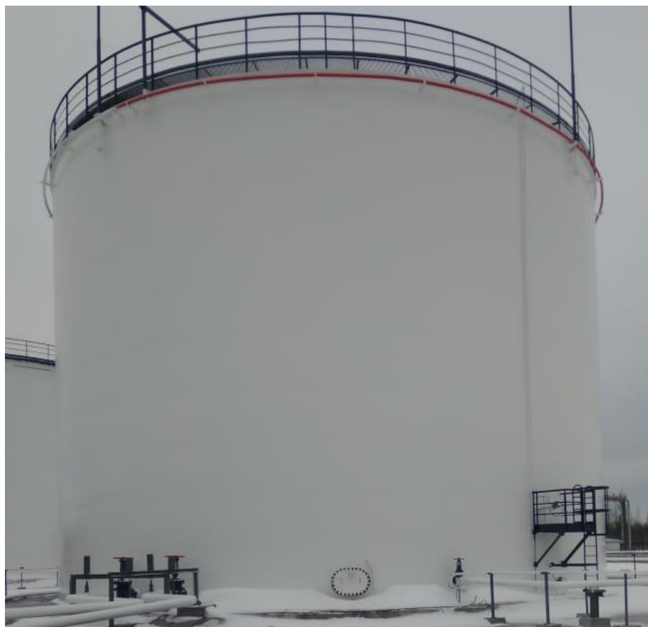
Рисунок 3 – Общий вид резервуара вертикального стального цилиндрического РВС-5000 Пломбирование резервуаров вертикальных стальных цилиндрических РВС-400, РВС-2000, РВС-5000 не предусмотрено.
