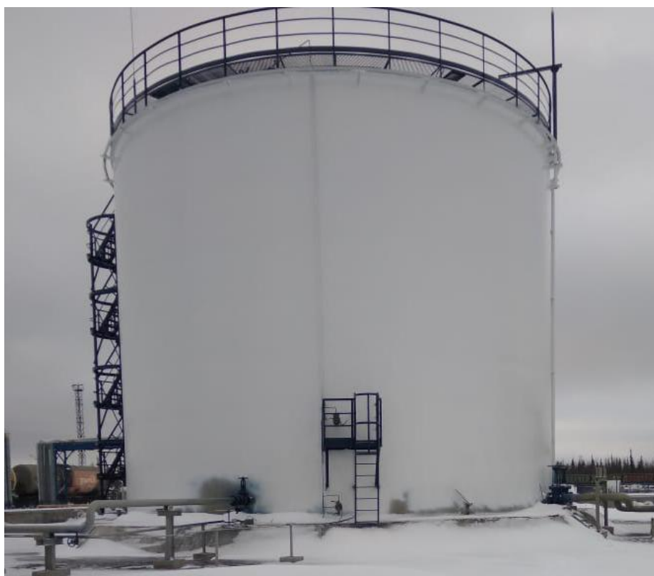
Рисунок 2 – Общий вид резервуара вертикального стального цилиндрического РВС-2000
