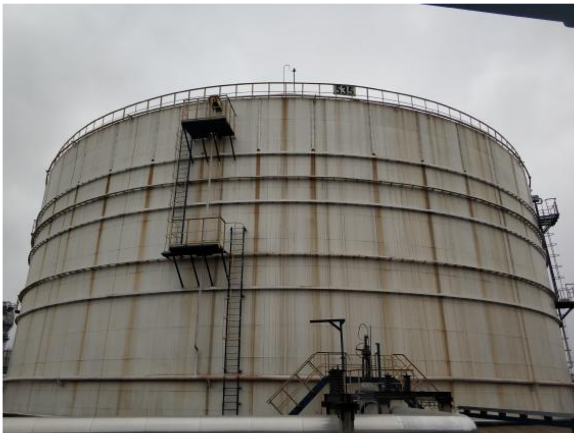
Рисунок 1 – Общий вид резервуара РВС-30000
