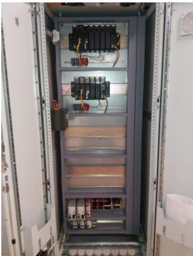
Рисунок 4 - Шкаф контроллера DCS
