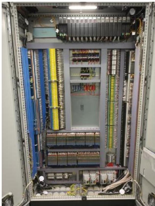
Рисунок 3 - Шкаф в/в IO4PLC (IO2PLC
