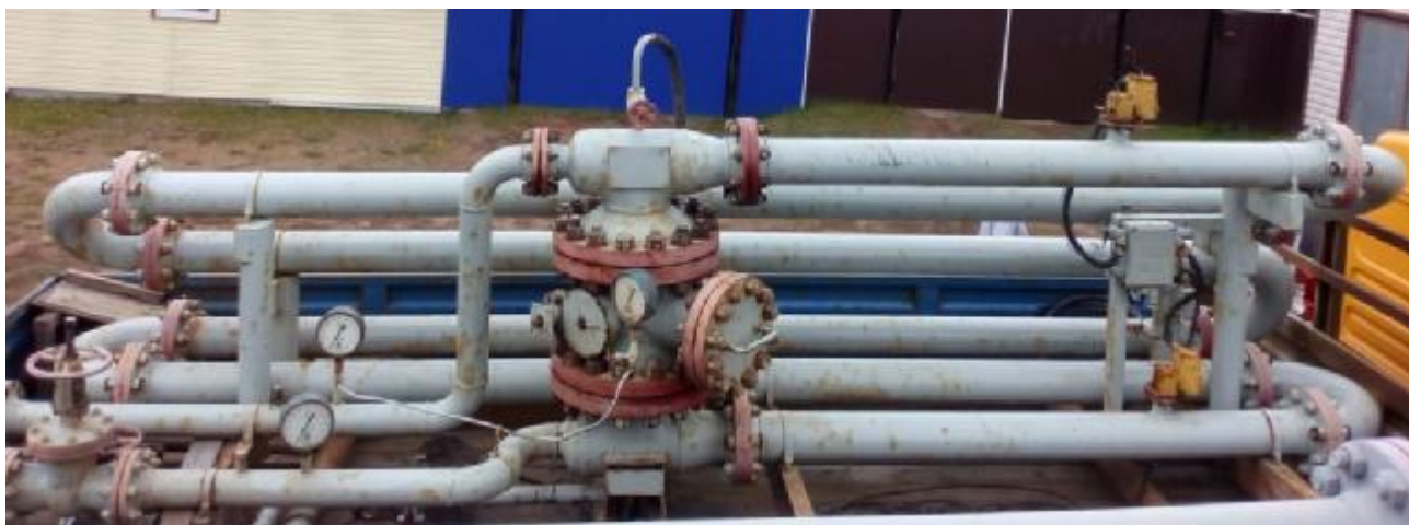
Рисунок 1 – Общий вид установки трубопоршневой ТПУ Сапфир М 100-4,0
