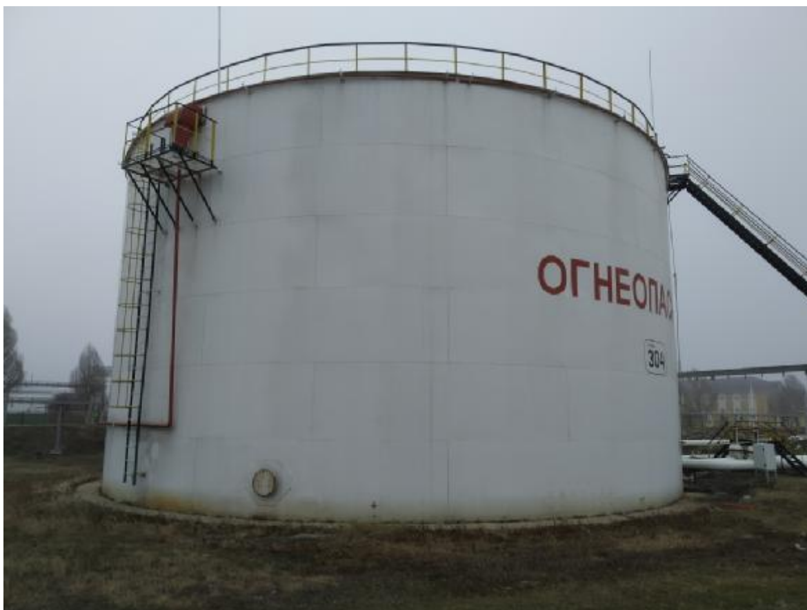
Рисунок 1 – Общий вид резервуаров стальных вертикальных цилиндрических РВС-5000
