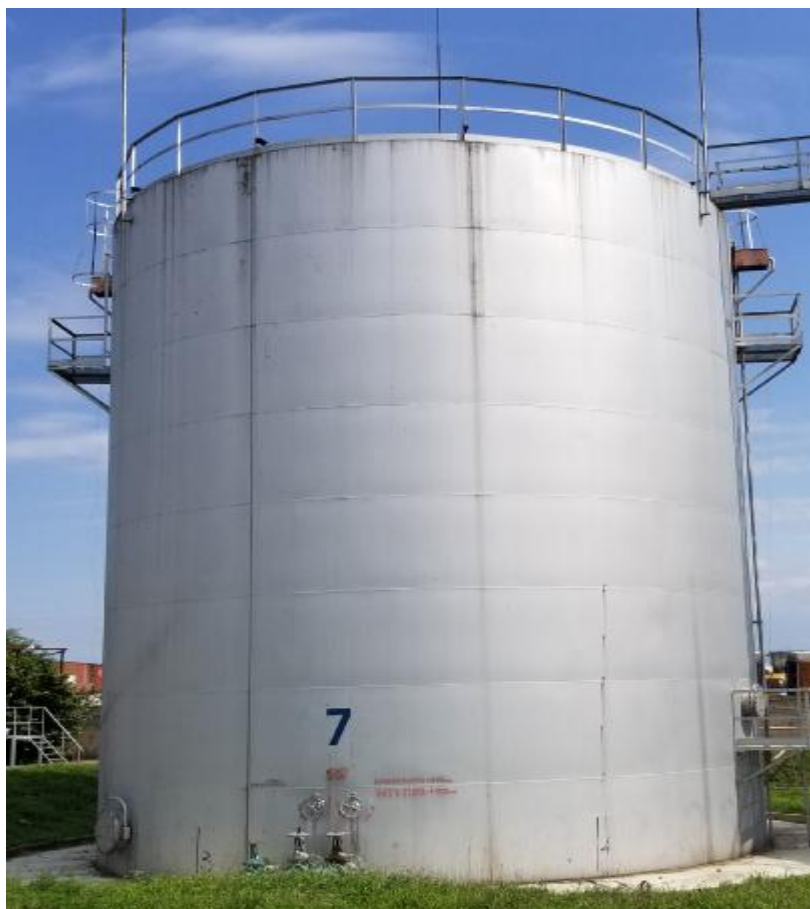
Рисунок 1- Общий вид резервуара РВС-1000, заводской № 7
