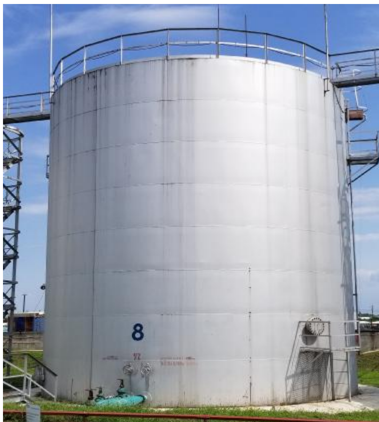
Рисунок 2 – Общий вид резервуара РВС-1000, заводской № 8
