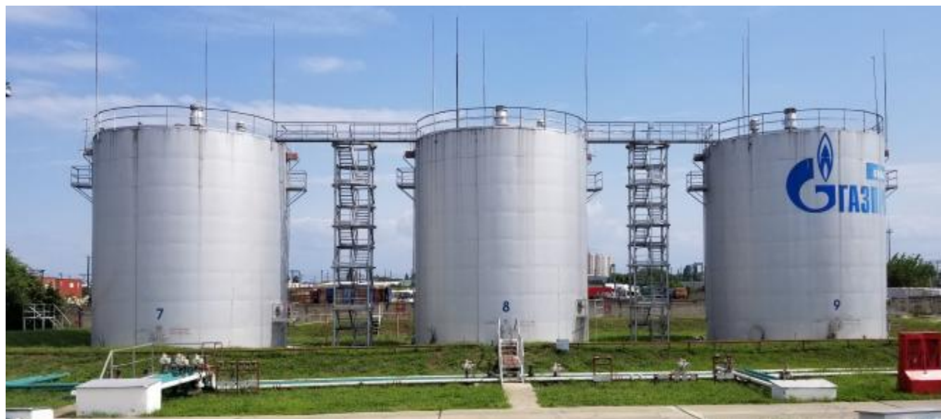
Рисунок 4 – Общий вид резервуаров РВС-1000, заводские №№ 7, 8, 9
