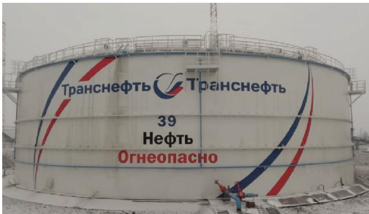
Рисунок 1 – Общий вид резервуара РВСП-20000
