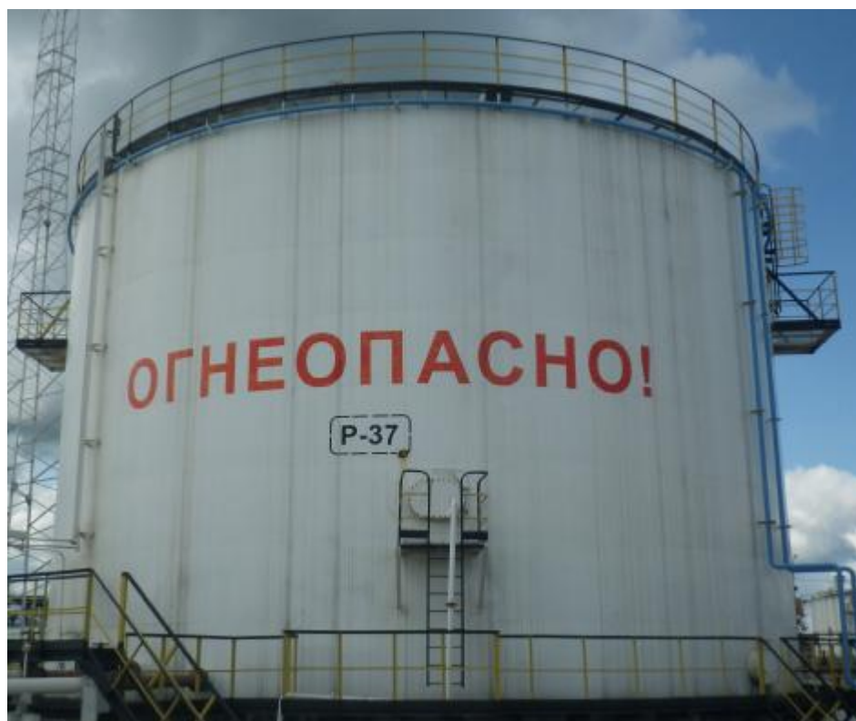
Рисунок 1 – Общий вид резервуаров стальных вертикальных цилиндрических РВСП-3000
