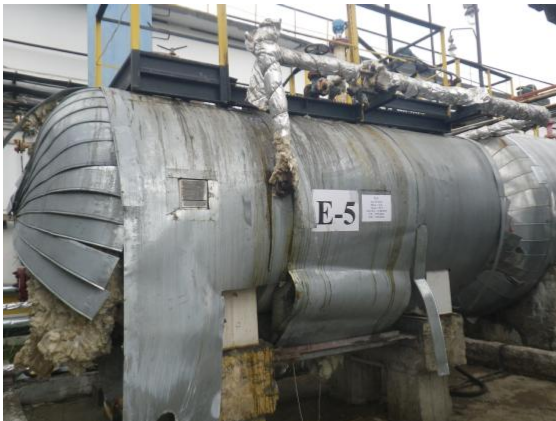
Рисунок 1 – Общий вид резервуара стального горизонтального цилиндрического РГС-8
