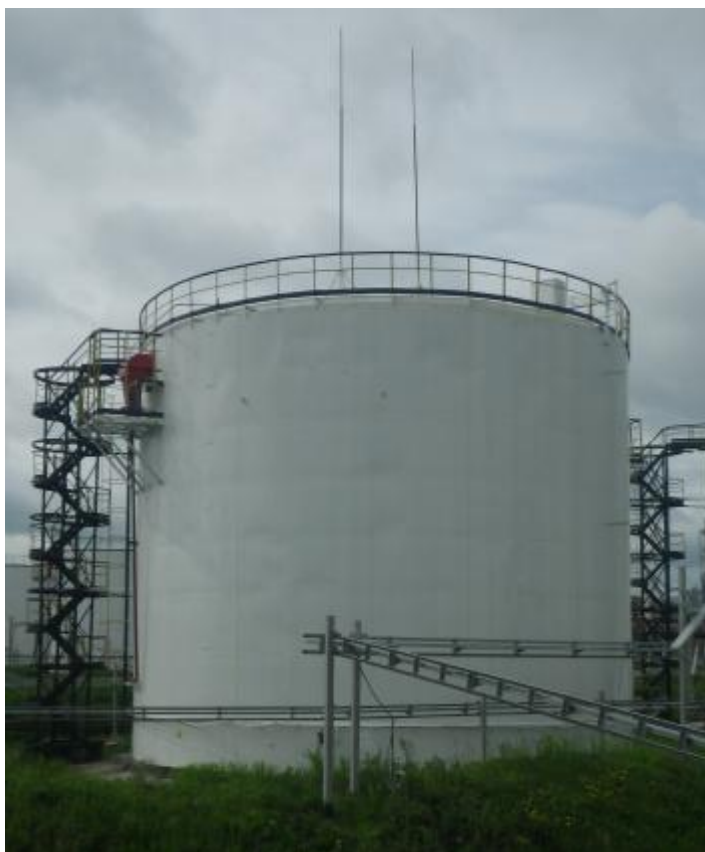
Рисунок 1 – Общий вид резервуаров стальных вертикальных цилиндрических РВС-2000
