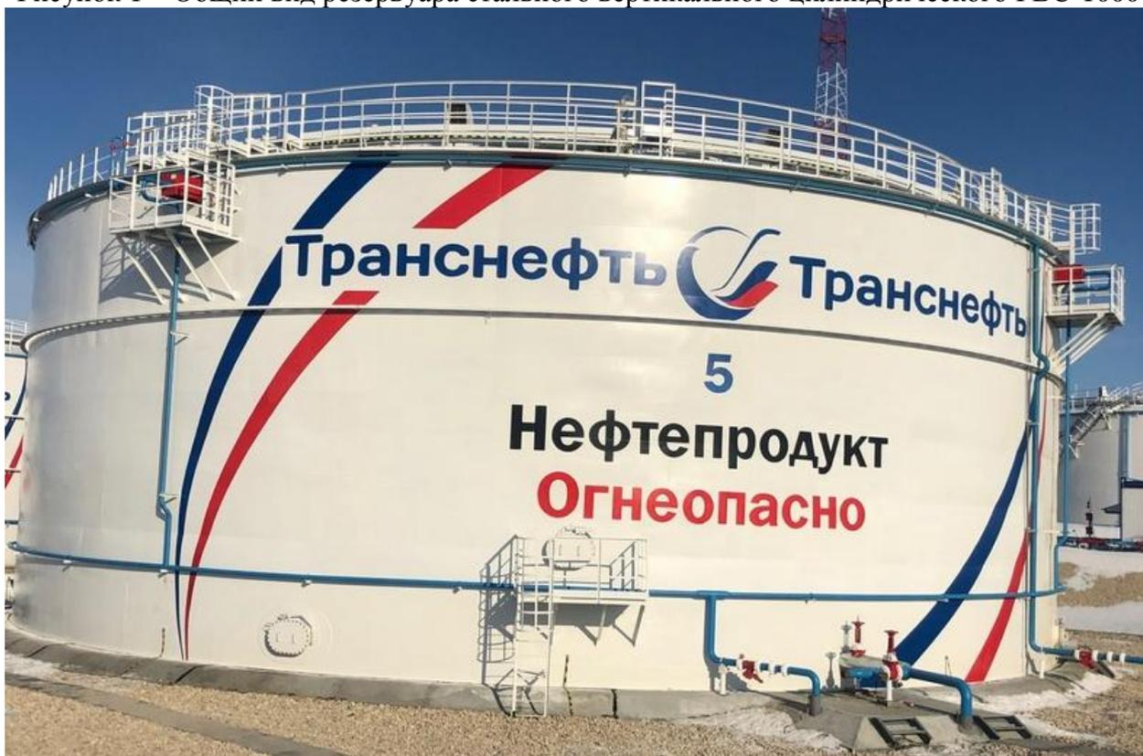
Рисунок 2 – Общий вид резервуара стального вертикального цилиндрического РВСП-10000
