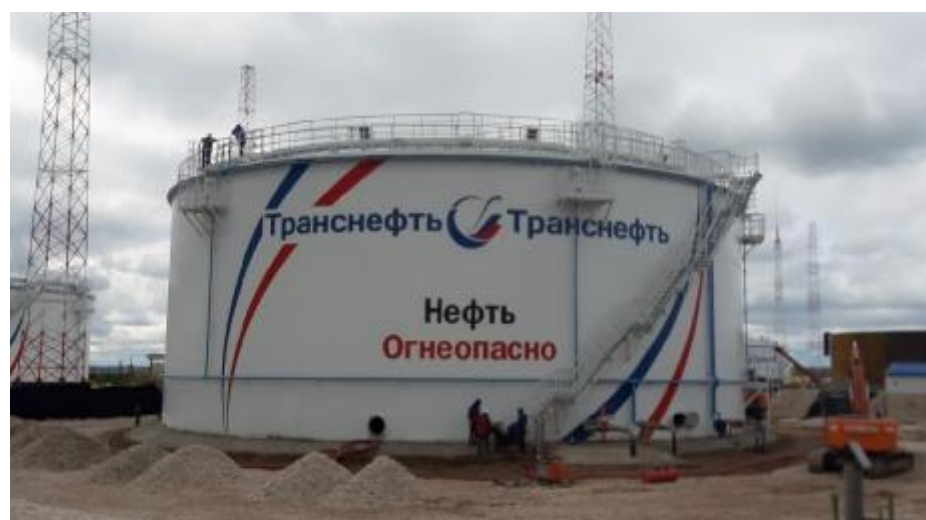
Рисунок 2 – Общий вид резервуаров РВСП-10000 зав.№№ 1, 2, 3, 4
