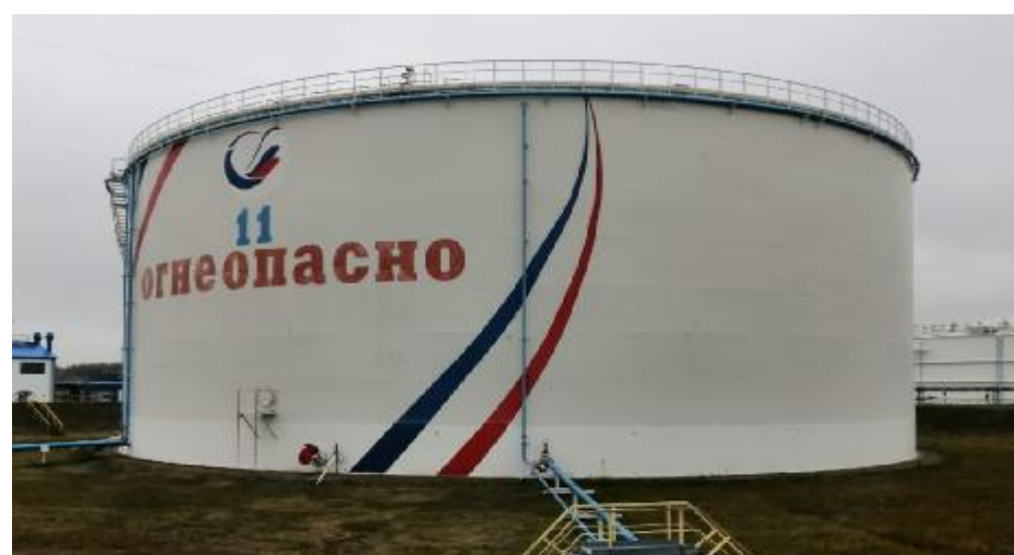
Рисунок 3 – Общий вид резервуара РВСП-30000 зав.№ 11
