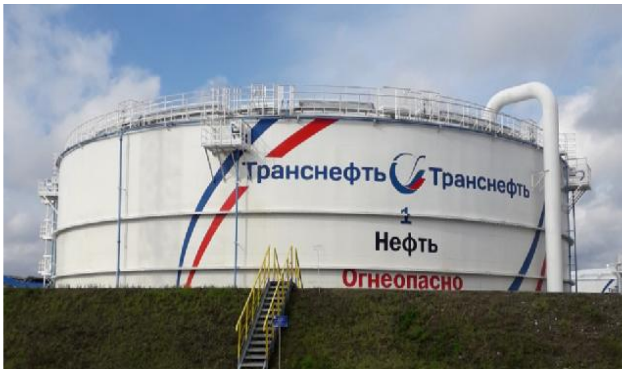
Рисунок 1 – Общий вид резервуара РВС-20000 зав.№ 1
