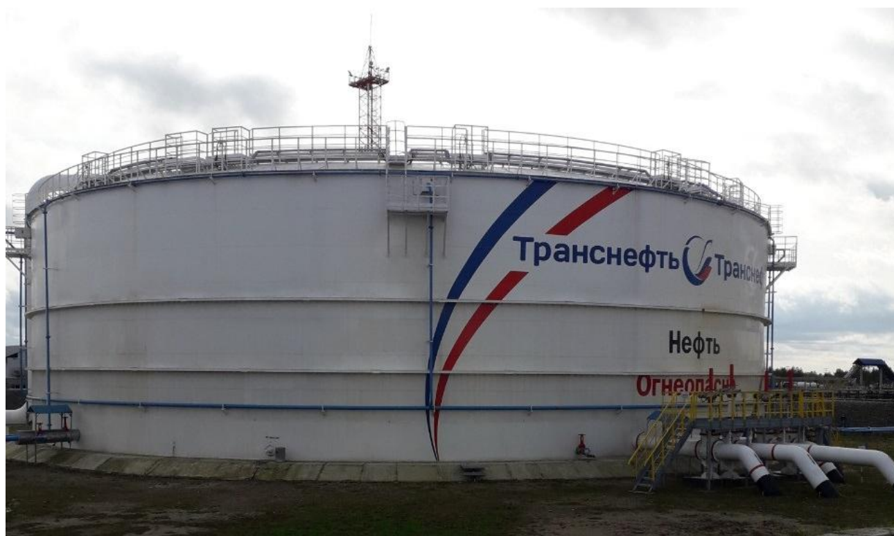
Рисунок 2 – Общий вид резервуаров РВСП-20000 зав.№№ 5, 6
