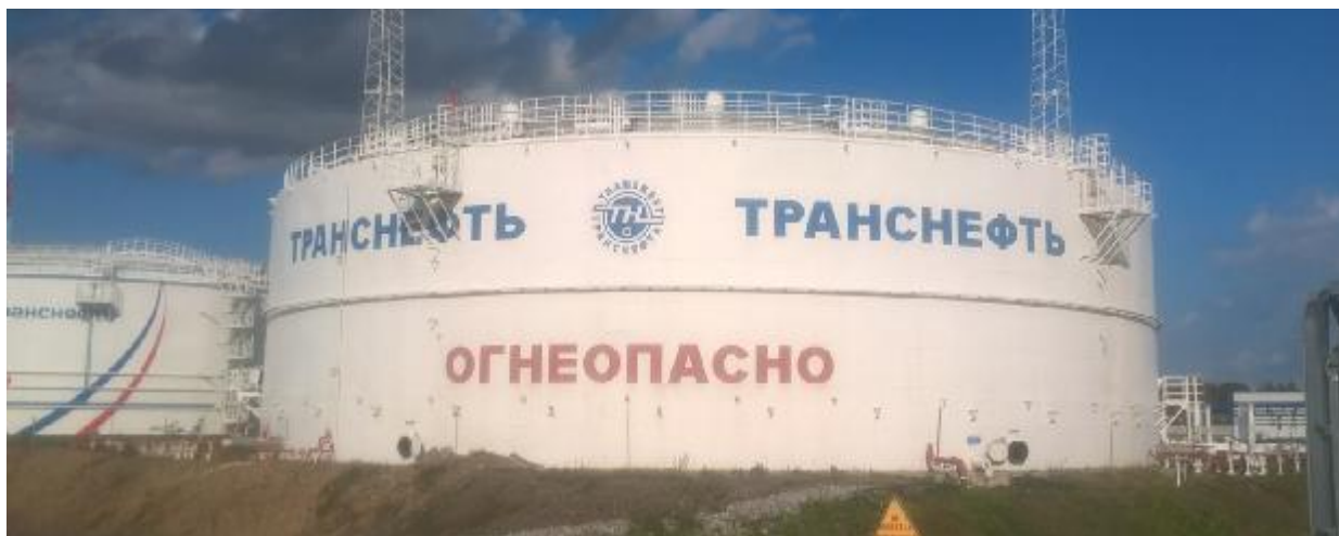
Рисунок 3 – Общий вид резервуаров РВСП-20000 зав.№№ 4, 9, 11
