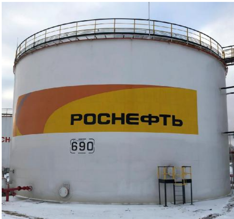
Рисунок 2 – Общий вид резервуара стального вертикального цилиндрического РВСП-5000
