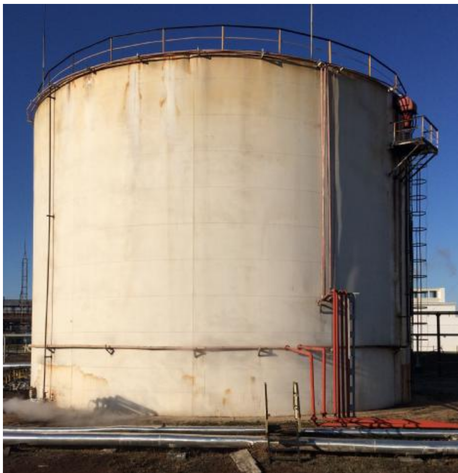
Рисунок 1 – Общий вид резервуара стального вертикального цилиндрического РВС-5000
