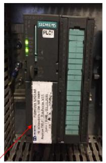
Рисунок 3 – Общий вид Место пломбирования контроллера
