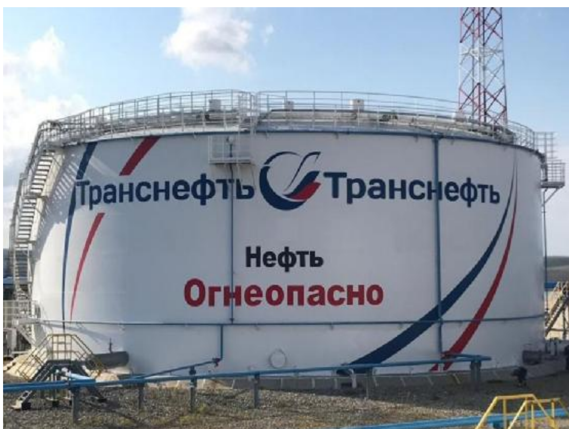
Рисунок 2 – Общий вид резервуаров РВСП-10000 зав.№№ 8, 9
