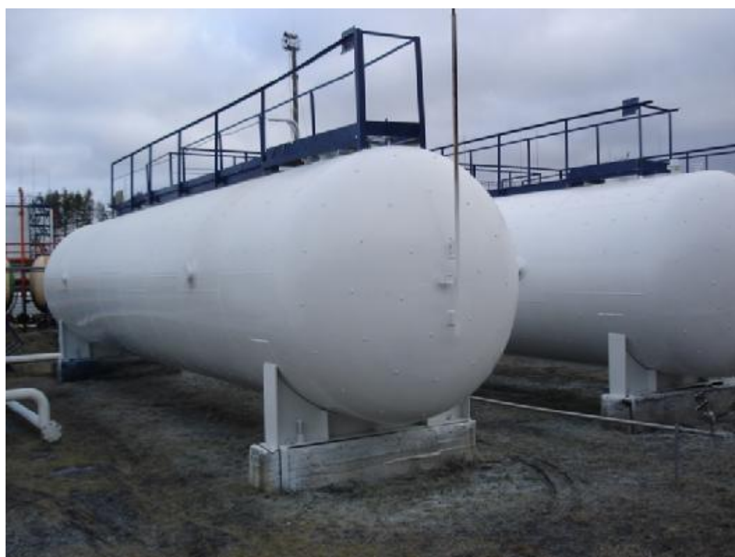
Рисунок 3 – Общий вид резервуара горизонтального стального цилиндрического РГС-100
