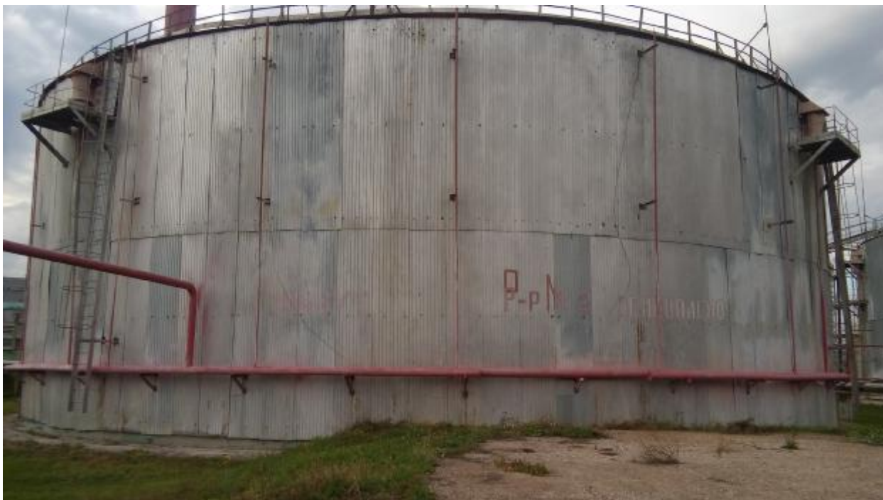
Рисунок 1 – Общий вид резервуаров стальных вертикальных цилиндрических РВС-10000 № 31, № 32
