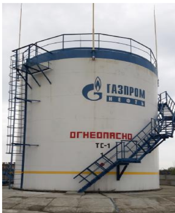
Рисунок 1 – Общий вид резервуара стального вертикального цилиндрического РВС-500
