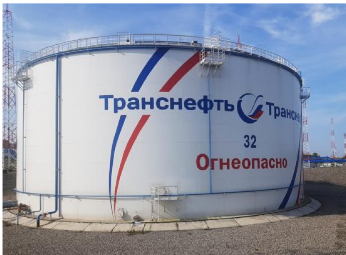
Рисунок 2 – Общий вид резервуара РВСП-30000 зав.№ 32
