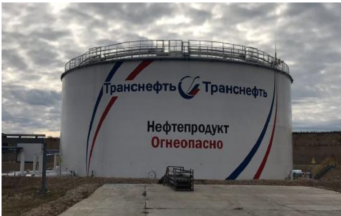
Рисунок 1 – Общий вид резервуаров РВС-10000 зав.№№ 1, 2, 3, 4, 5, 6, 7, 8
