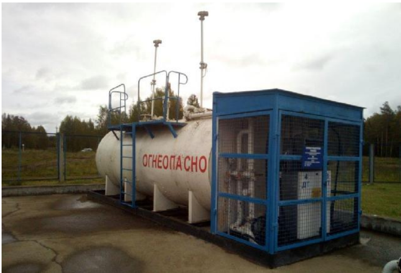
Рисунок 1 – Общий вид резервуара РГС-20
