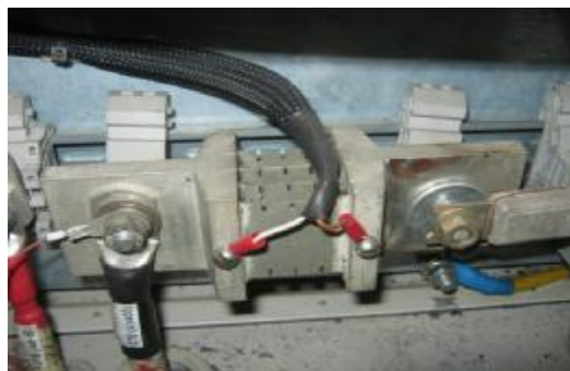
Рисунок 8 – Шунт измерительный 75ШИСВ.1-1000
