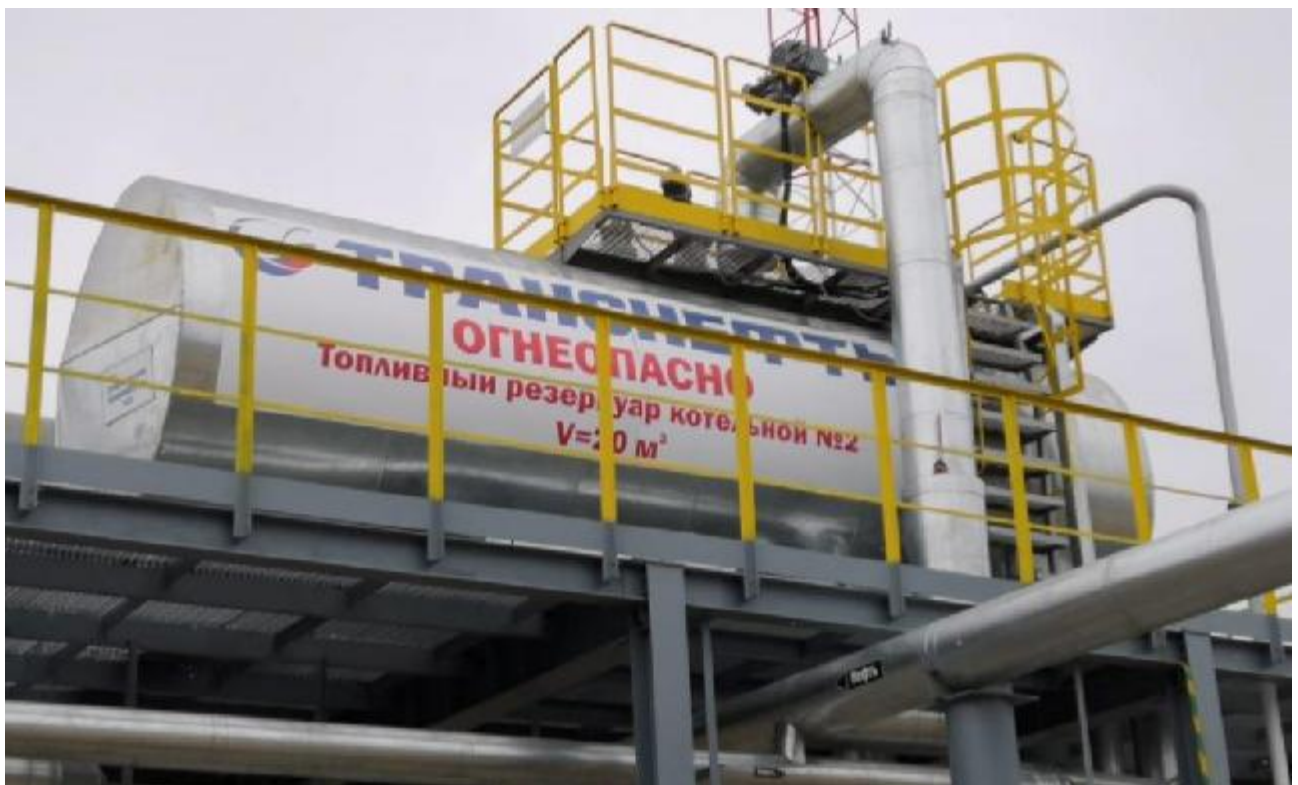
Рисунок 1 – Общий вид резервуара стального горизонтального цилиндрического РГС-20 (17+3)
