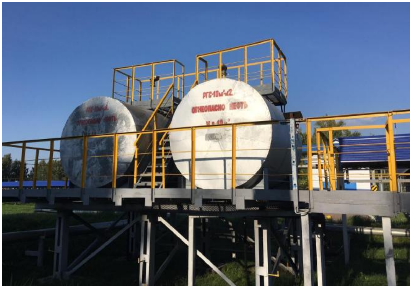
Рисунок 1 – Общий вид резервуаров стальных горизонтальных цилиндрических РГС-10
