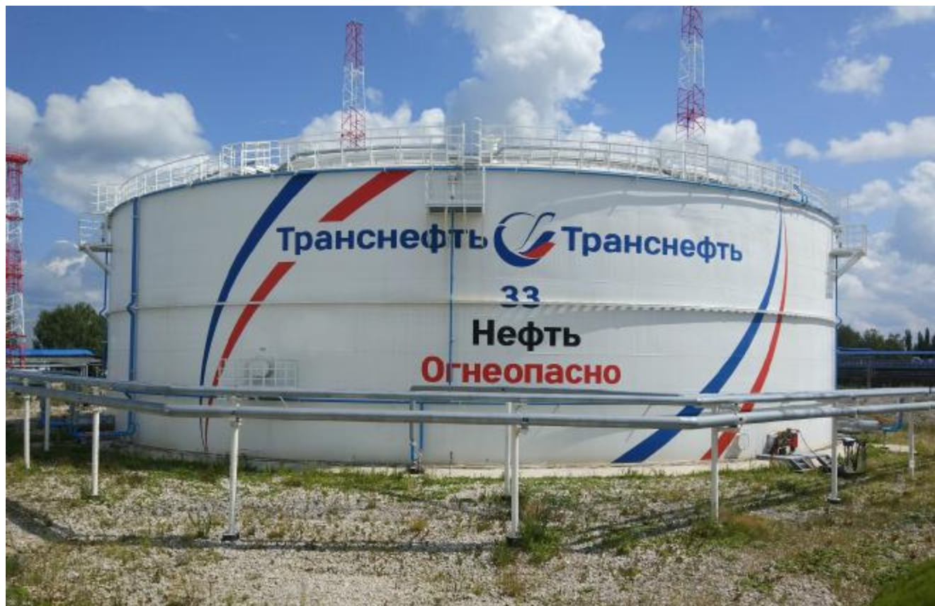
Рисунок 1 – Общий вид резервуара РВСП-20000
