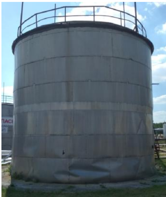
Рисунок 4 – Общий вид резервуара стального вертикального цилиндрического РВС-400
