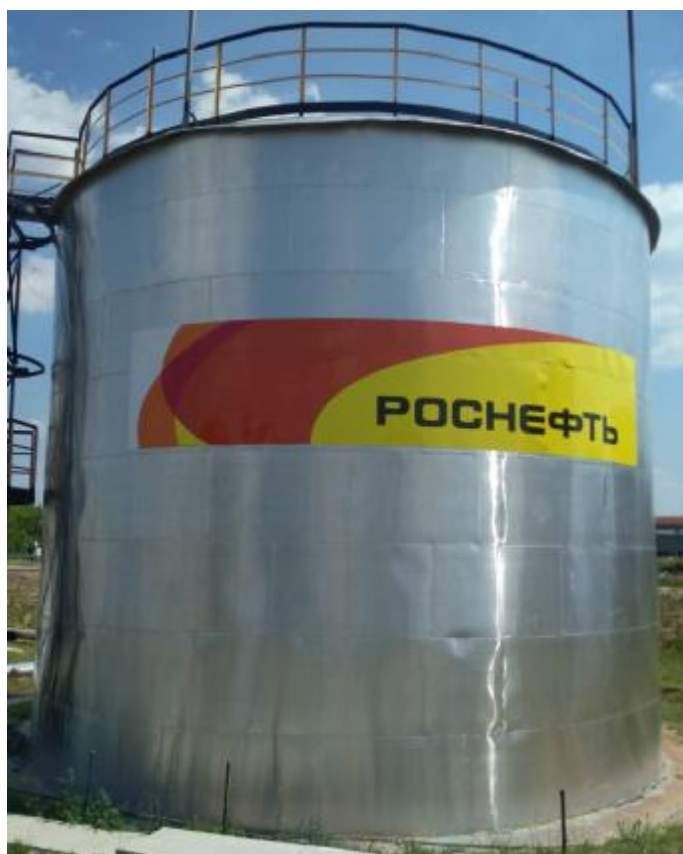
Рисунок 5 – Общий вид резервуара стального вертикального цилиндрического РВС-700
