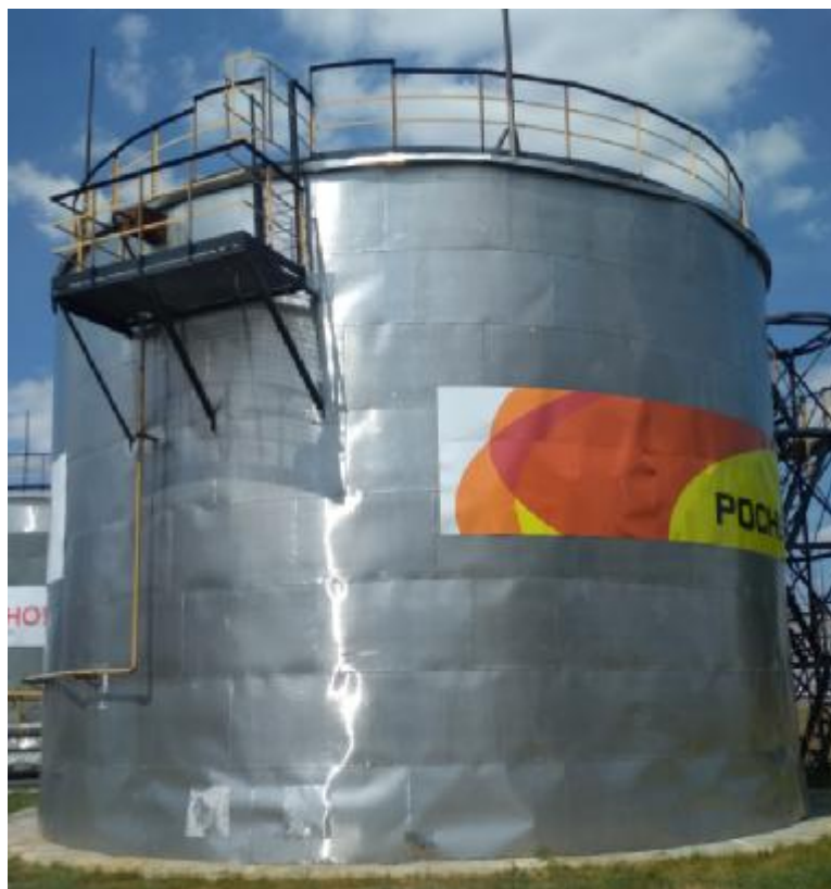
Рисунок 6 – Общий вид резервуара стального вертикального цилиндрического РВС-1000
