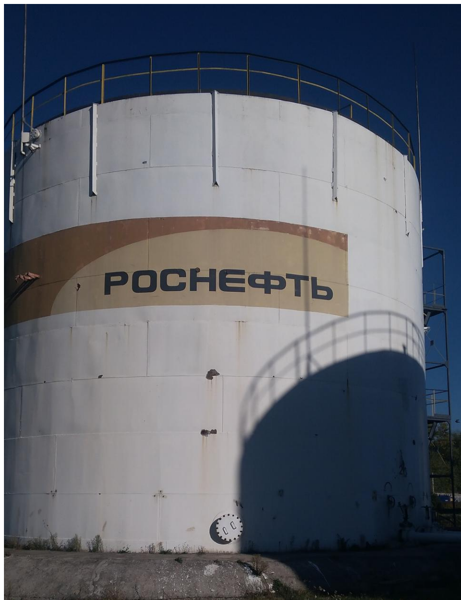
Рисунок 2 – Общий вид резервуара стального вертикального цилиндрического РВС-2000
