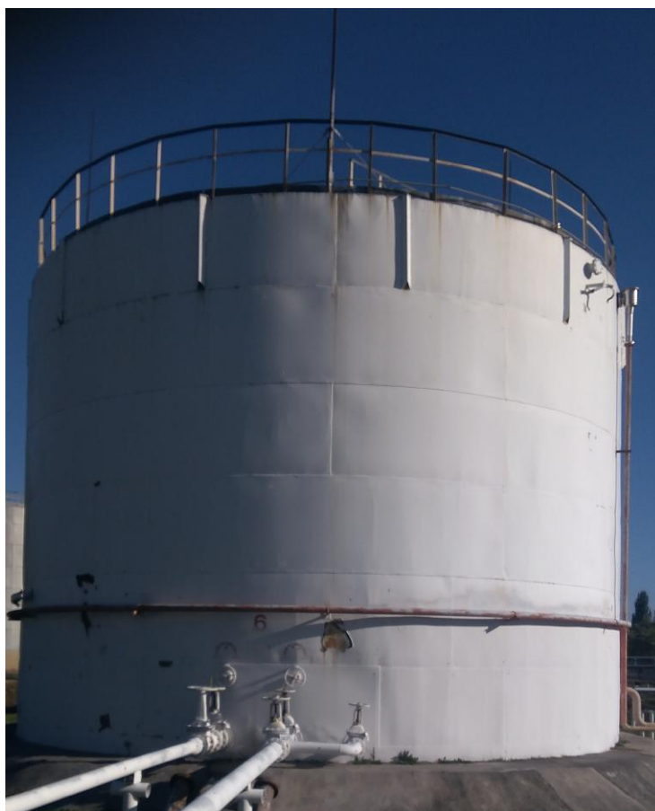
Рисунок 1 – Общий вид резервуара стального вертикального цилиндрического РВС-1000, РВСП-1000
