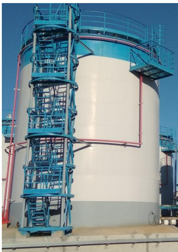
Рисунок 1 – Общий вид резервуаров стальных вертикальных цилиндрических РВСП-1000
