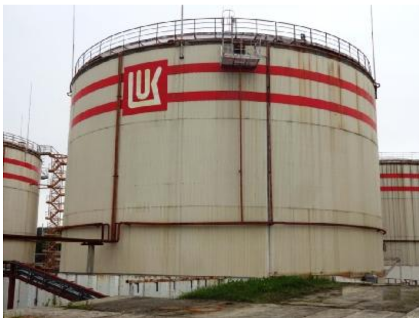
Рисунок 1 – Общий вид резервуаров РВСП-10000 №№ 255, 256, 258
