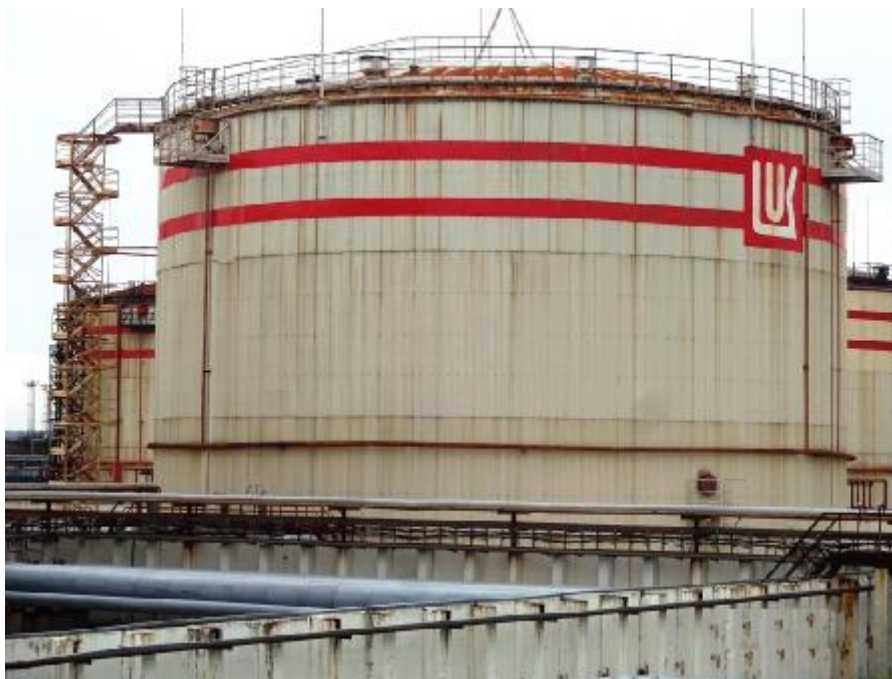
Рисунок 2 – Общий вид резервуара РВС-10000 № 257
