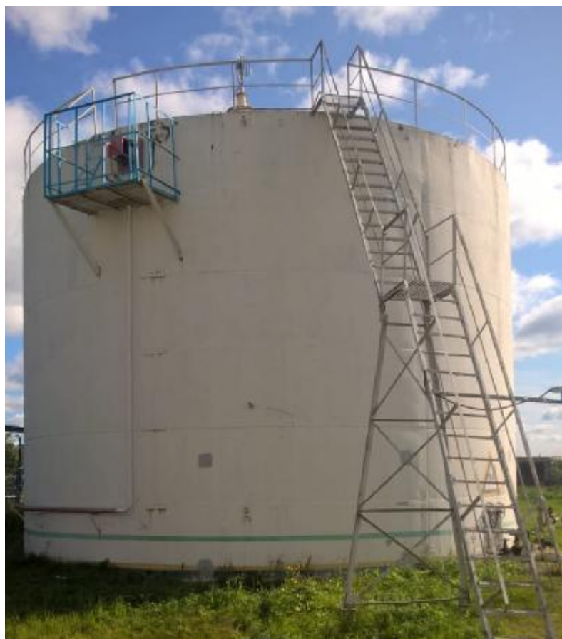
Рисунок 2 – Общий вид резервуара вертикального стального цилиндрического РВСП-1000
