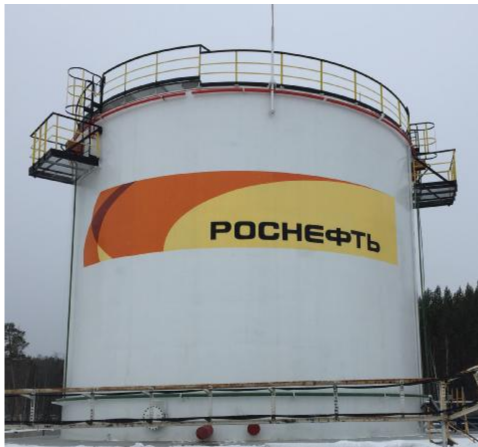
Рисунок 1 – Общий вид резервуара стального вертикального цилиндрического РВС-2000
