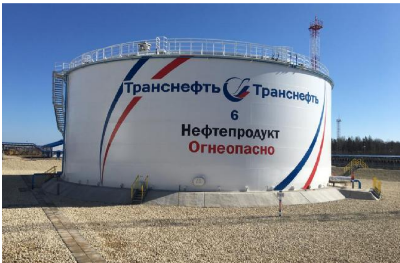
Рисунок 1 – Общий вид резервуара РВС-10000
