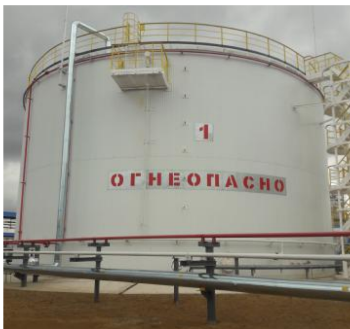
Рисунок 1 – Общий вид резервуара стального вертикального цилиндрического РВС-5000
