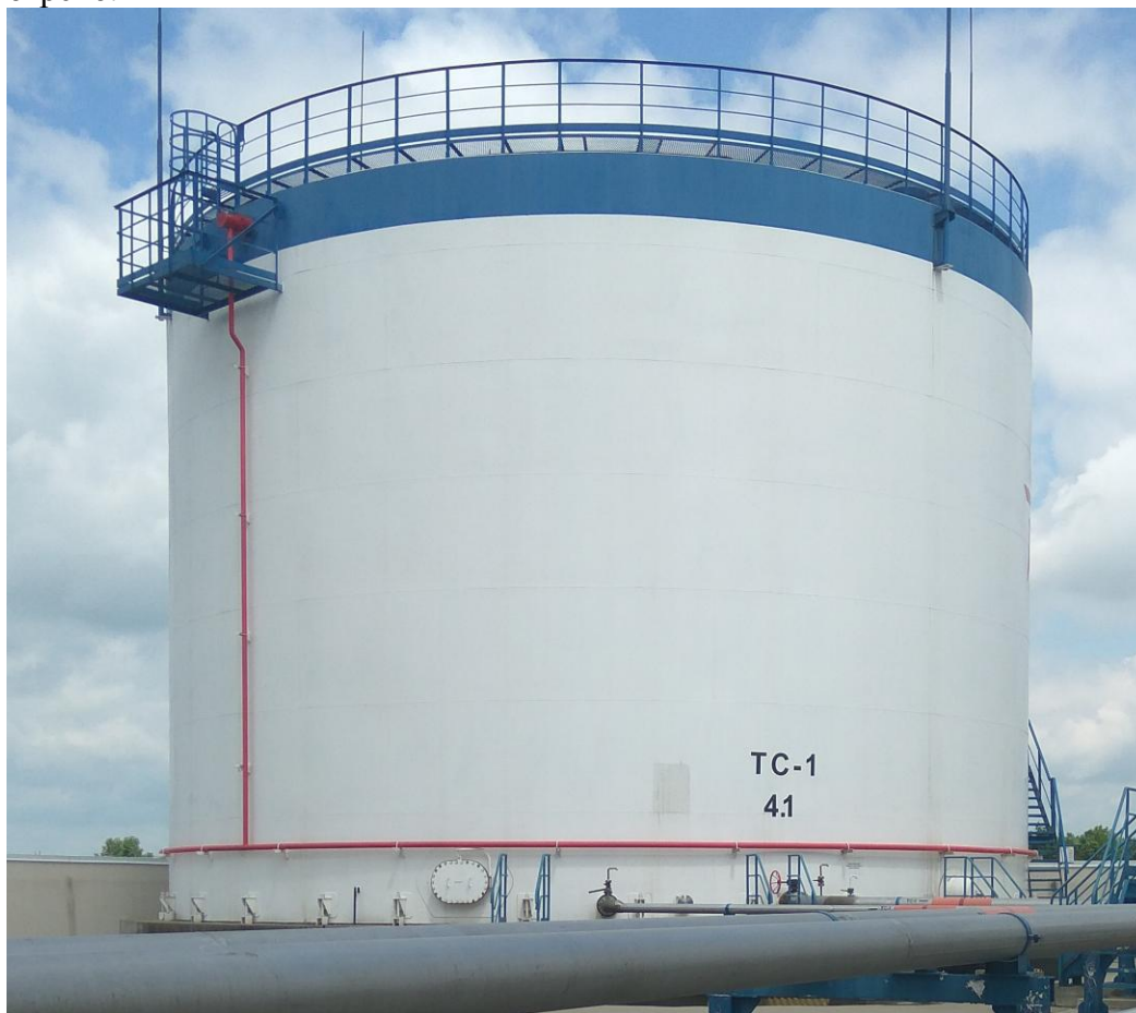
Рисунок 1 – Общий вид резервуаров стальных вертикальных цилиндрических РВС-3000
