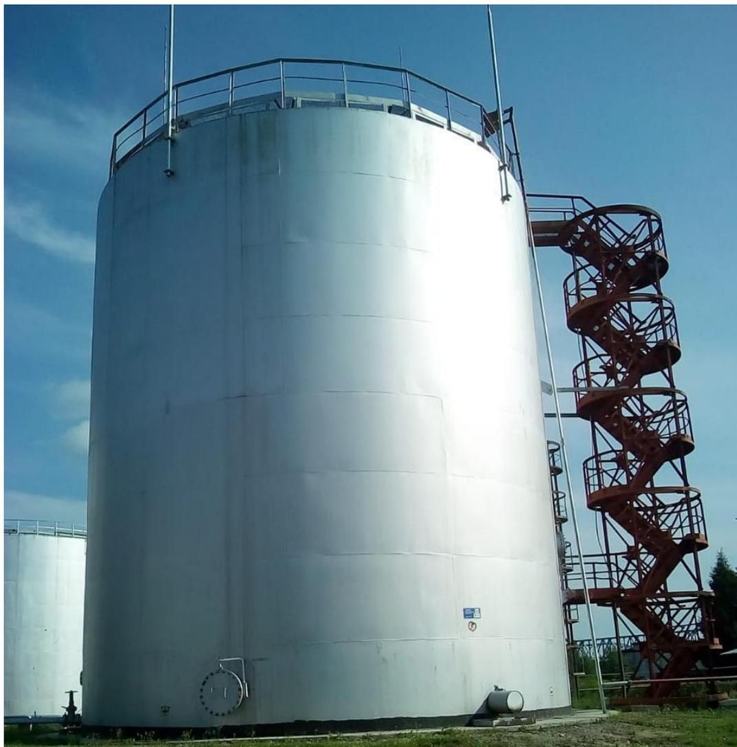
Рисунок 1 – Общий вид резервуара стального вертикального цилиндрического РВСП-1000
