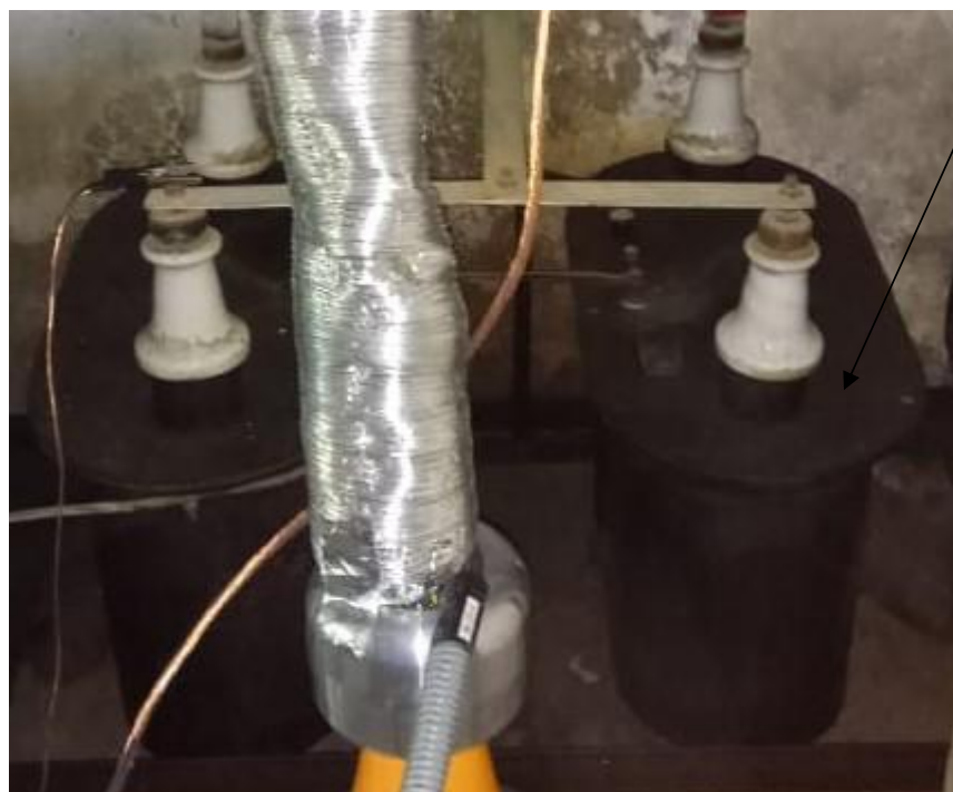
Рисунок 1 - Общий вид трансформатора напряжения НОМ-10 с указанием мест нанесения знака поверки
